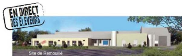
Le site de la future laiterie, à Remouillé (44)
